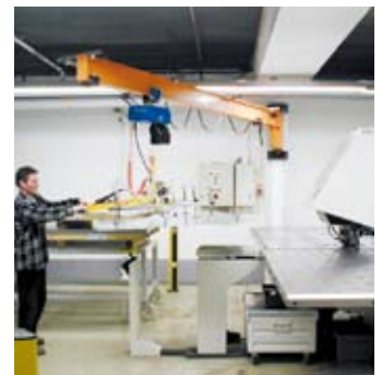
Wandschwenkran mit Vakuum-Handhabungsgerät beim Beschicken einer Stanzmaschine
