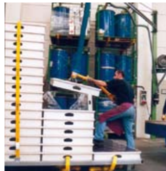
Abstapeln von Verschalungselementen
